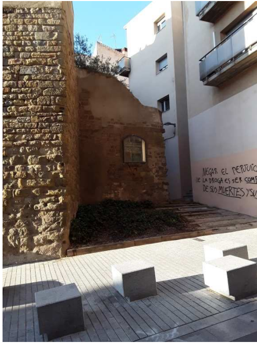
parterre carrer Joc de la Pilota
